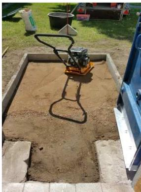
Jetzt mußten die Randsteine rechts und links sowie am Wegende gesetzt werden. Um eine Standfestigkeit zu gewährleisten, wurden diese
